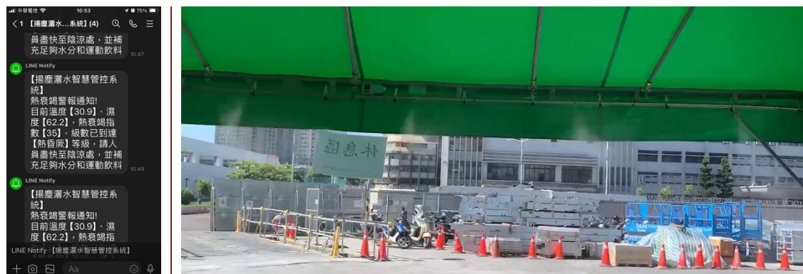
營造車站工地休息區實績
