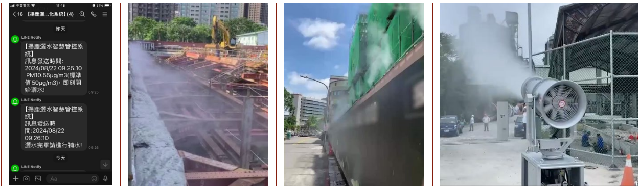
現場灑水示意圖：建設工地圍籬灑水實績
