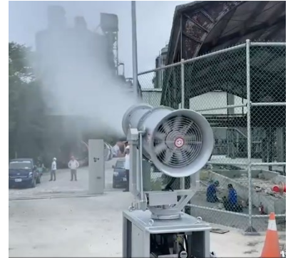
現場灑水示意圖：建設工地圍籬灑水實績
