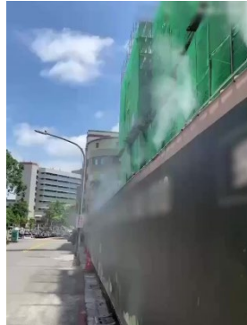
現場灑水示意圖：建設工地圍籬灑水實績
