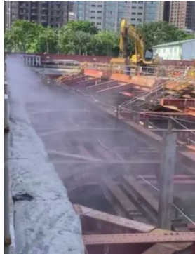
現場灑水示意圖：建設工地圍籬灑水實績
